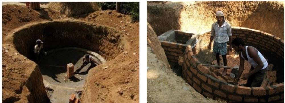
Figure 4-36: Construction d'un digesteur biogaz à dôme fixe
