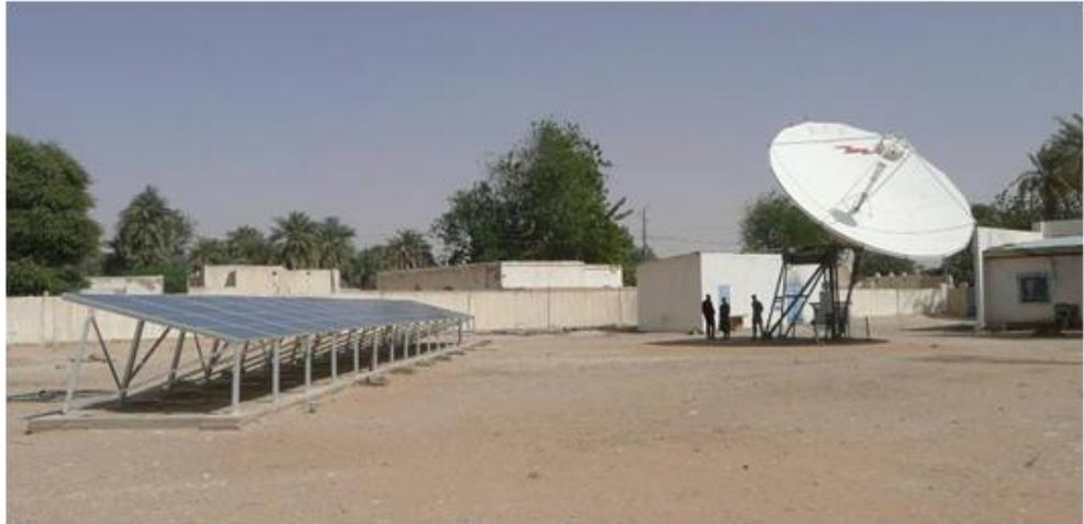
**Figure 4-12: Exemple de système autonome de plusieurs kW, Sotel à Faya**
